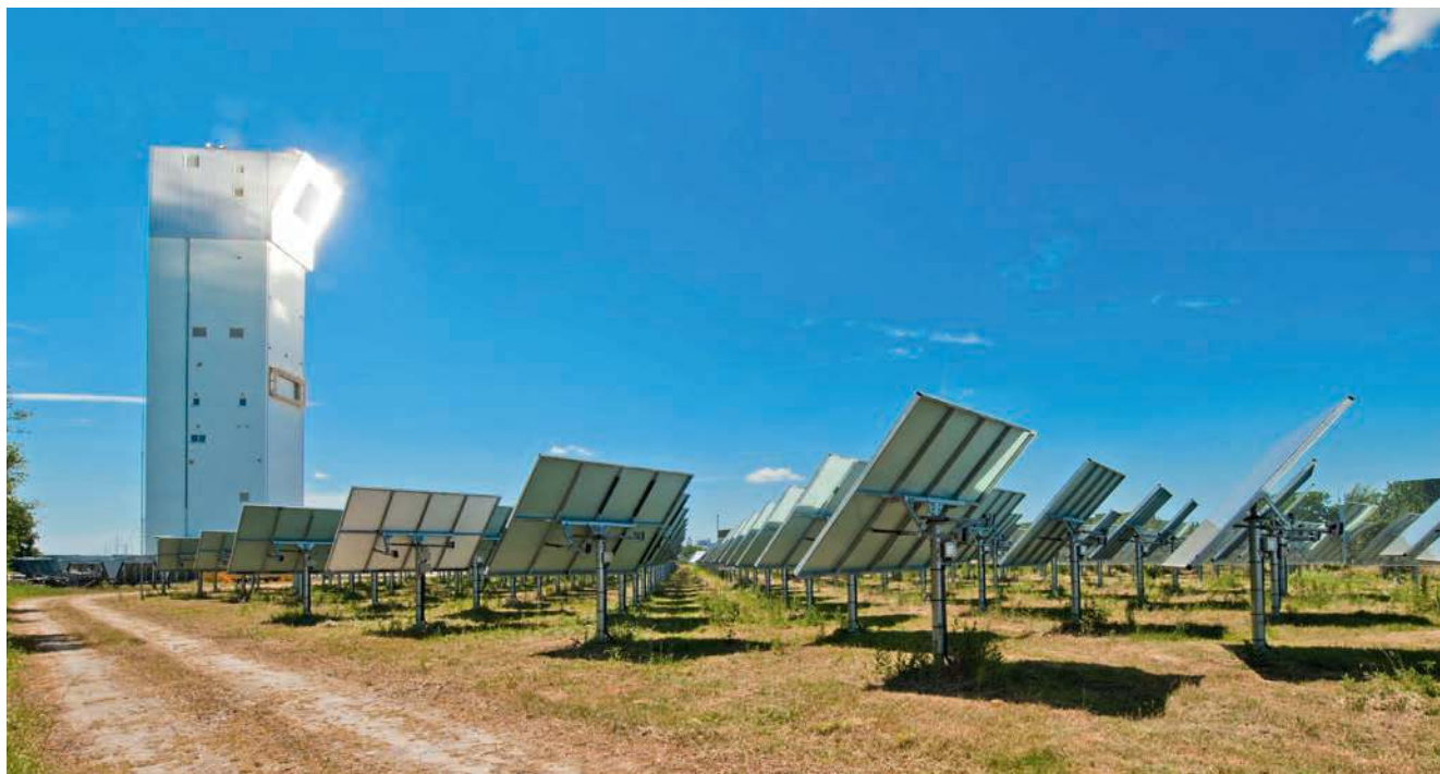
Solarturm Jülich: Auf einer Fläche von ca. zehn Hektar lenken mehr als 2.000 bewegliche Spiegel die einfallenden Sonnenstrahlen auf die Spitze des 60 Meter hohen Solarturms. Als Kraftwerk benutzt erzeugt die Anlage Wasserdampf, der per Turbine und Generator Strom erzeugt.
