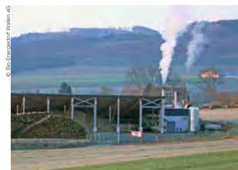
Biogasanlage des Energiedorfs Wallen
